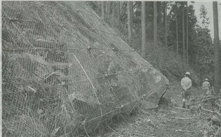
東日本大震災でも効果が確認された、落石のエネルギーを吸収する「RCネット工法」=2011年3月11日、岩手県奥州市
